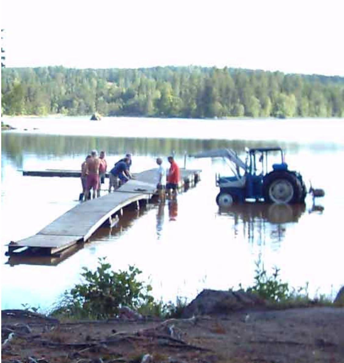
Ögonblicksbild från sommarens reparation av bryggorna vid Siktjärn.
